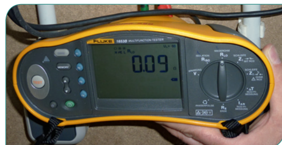
3 Messen der Niederohmigkeit des Schutzleiters
