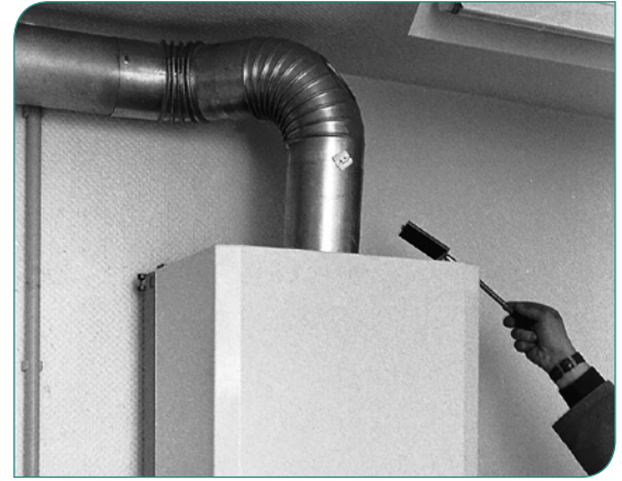
1 Funktionsprüfung mit Taupunktplatte
