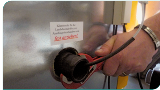
3 Halterohr für die Lambdasonde
