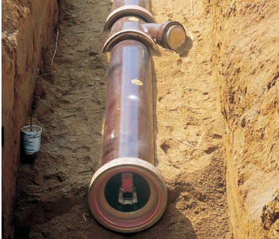
Rohrbettung und Ausrichtung mittels Laser
