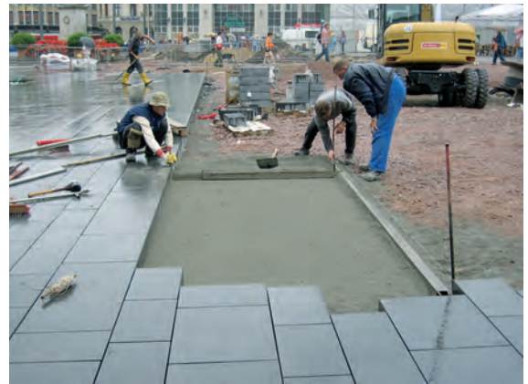
Die Bettung wird abgezogen (hier Betonbett)
