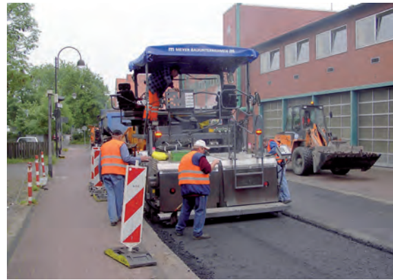
Einbau der Binderschicht
