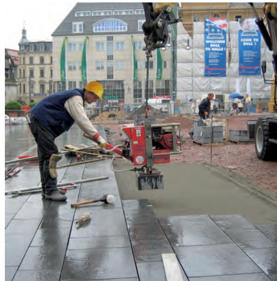
Verlegen von Natursteinplatten
