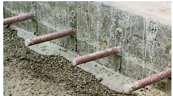
Eingebaute Dübel
