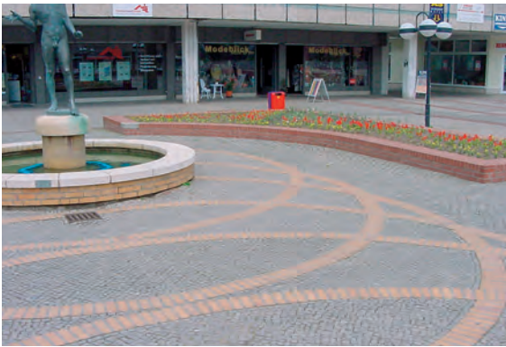
Kombination von Klinker- und Natursteinpflaster
