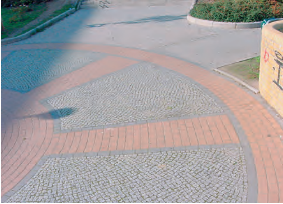
Kleinpflaster durch Betonpflaster unterbrochen
