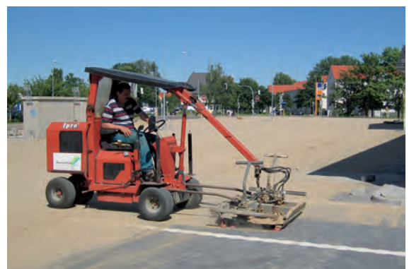
Der Fugensand wird eingekehrt
