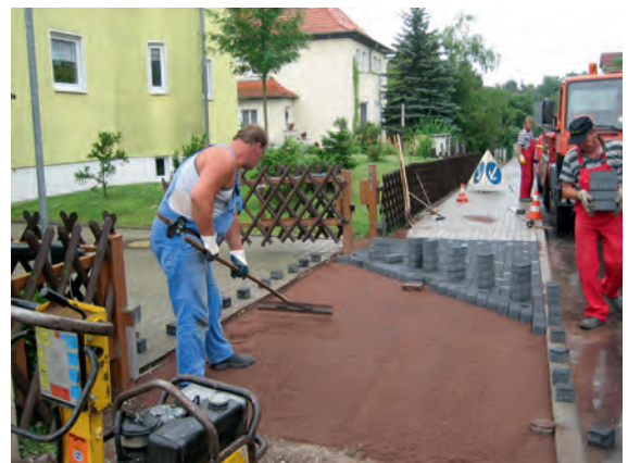
Nochmaliges Glätten nach der Verdichtung der Bettung
