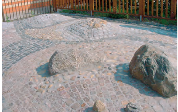
Überpflastern von Hügeln und Einbau von Findlingen
