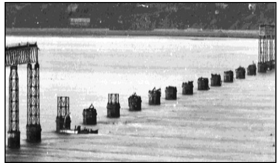
Eingestürzter Mittelteil der Brücke
