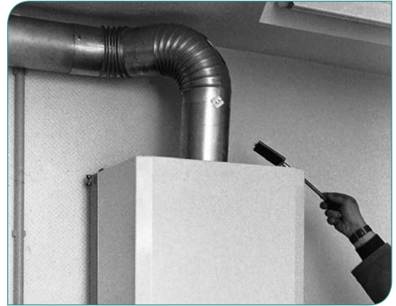
1 Funktionsprüfung mit Taupunktplatte
