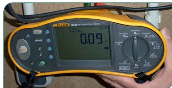
3 Messen der Niederohmigkeit des Schutzleiters
