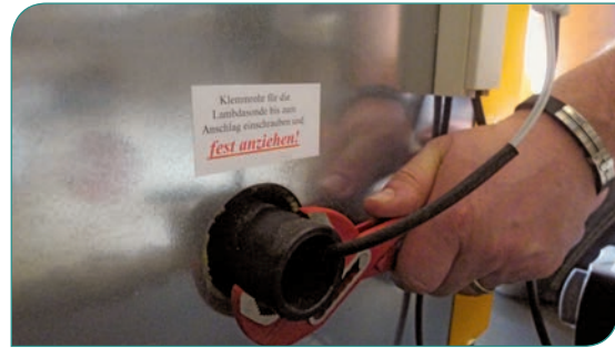
3 Halterohr für die Lambdasonde
