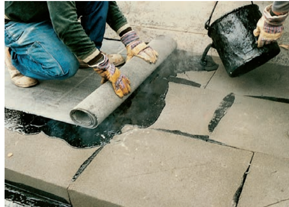
Verlegen von Dachdichtungsbahnen (Gießverfahren)
