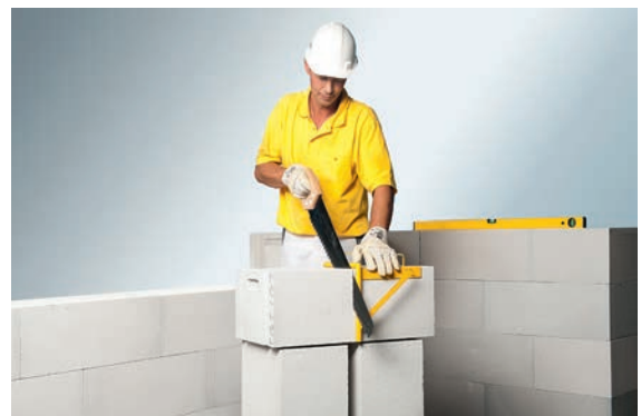
Maß- und passgenaues Sägen der Porenbetonsteine
