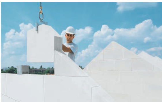
Versetzen von Kalksand-Planelementen
