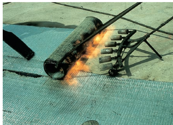
Verlegen von Schweißbahnen
