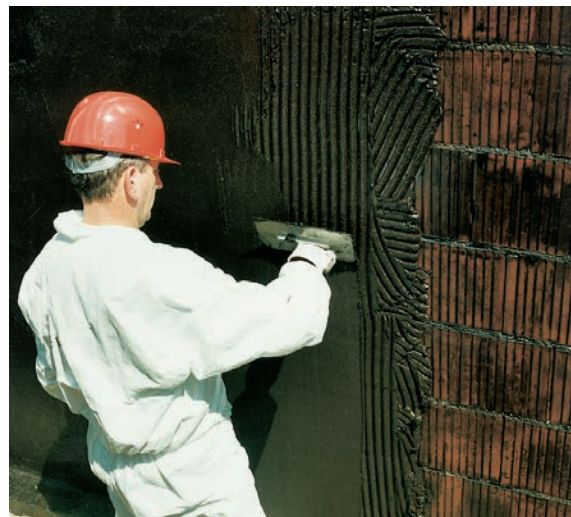
Aufbringen einer Dickbeschichtung
