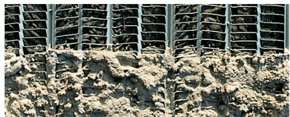
Rippenstreckmetall als Putzträger mit Spritzbewurf
