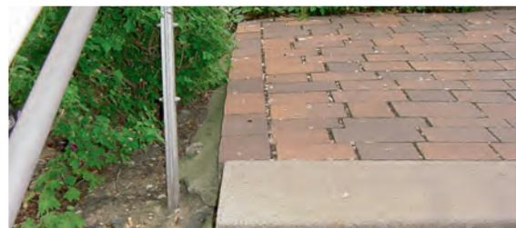
Unzureichende Rückenstütze: Das Pflaster rutscht weg, Fugen vergrößern sich, der nächste Frost wird weitere Schäden hervorrufen
