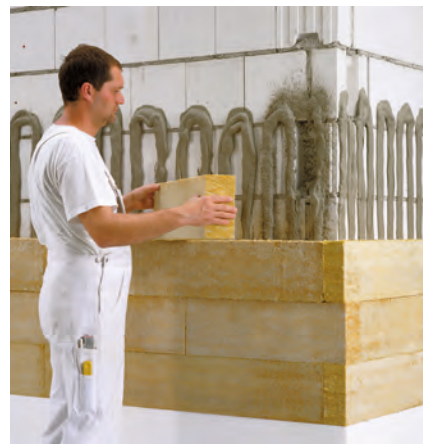
Maschineller Kleberauftrag auf den Untergrund im Teilflächenverfahren
