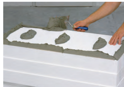
Kleberauftrag von Hand im Punkt-Wulst-Verfahren
