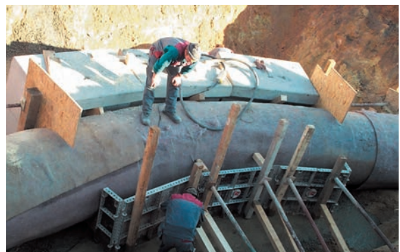
Rohrwiderlager aus Ort beton
