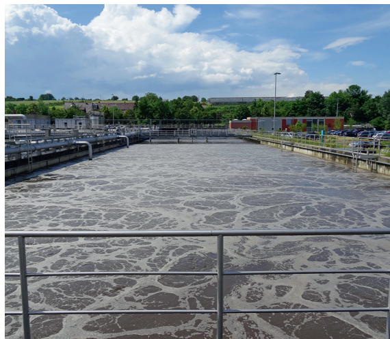
Belebungsbecken zur biologischen Abwasserreinigung
