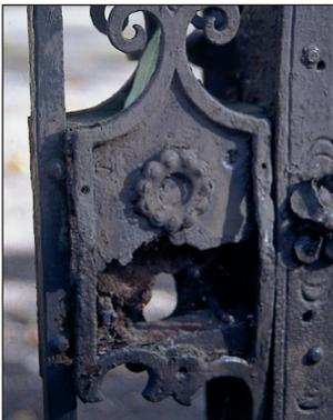
**Bild 1** Schlosskasten, durch Korrosion zerstört: Schloss Dresden
