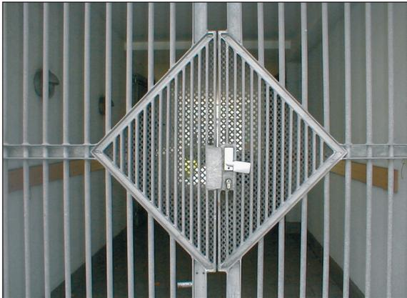
**Bild 1 Torgitter:** korrosionsbeständig, schweißbar, geringe Kosten, hohe Festigkeit (Marsstraße, München)
