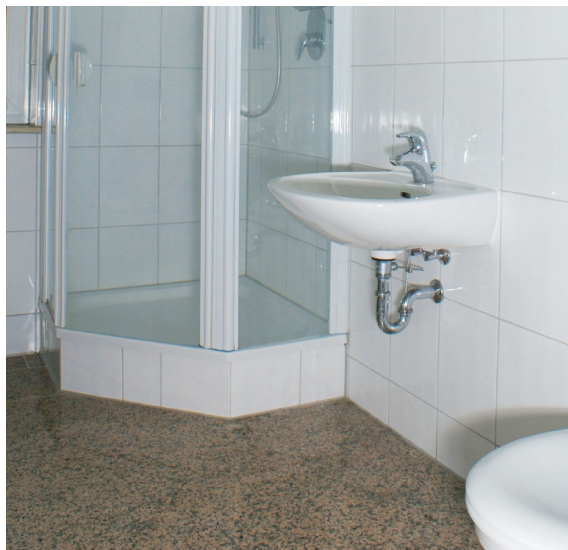
1 Vorhandene Waschbecken, Duschkabinen und WCs in den Waschräumen
